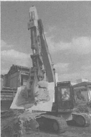
解体には高額費用がかかる
