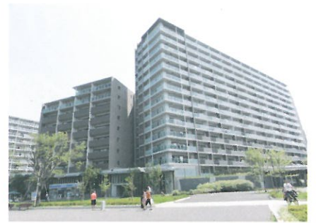
高齢者施設や保育所なども併せて整備された、多摩ニュータウンの諏訪二丁目団地
